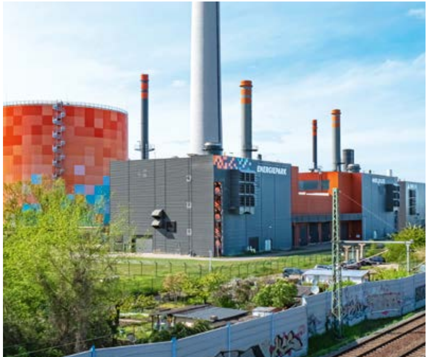
Im Energiepark Dieselstraße wird der Großteil für die hallesche Fernwärmeversorgung produziert.
