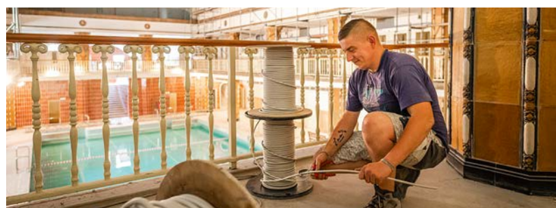
Etwa 30 Kilometer Kabel wurden im Stadtbad neu verlegt.
