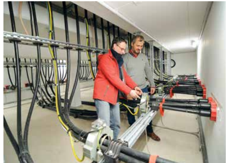
Hingucker in der Blücherstraße: Das Schalthaus Weinberg ist nach zwei Jahren fertiggestellt und nimmt seine Arbeit auf.
