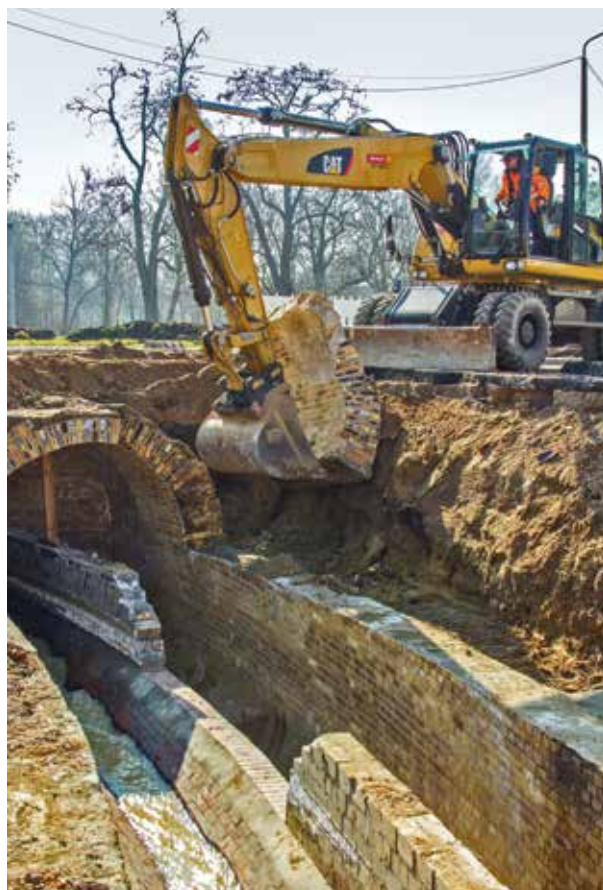
Der Böllberger Weg wird grundhaft saniert und fit gemacht.
